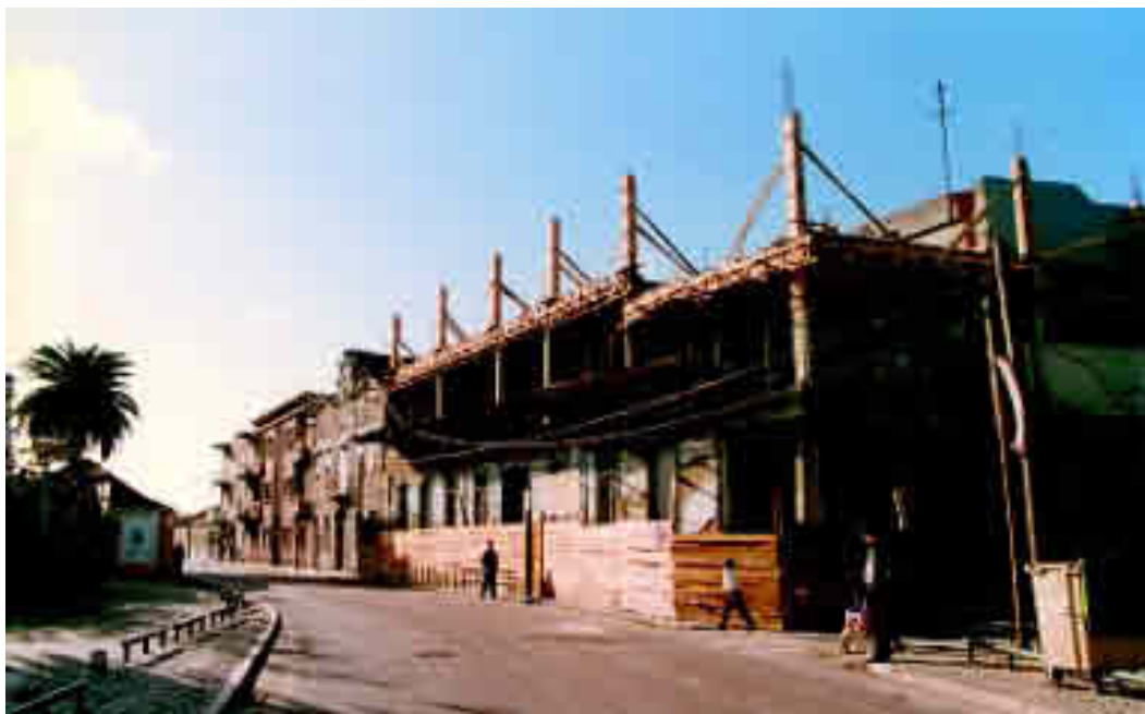
Segunda fase das obras da sede social.
